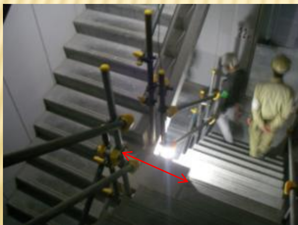
階段間に乗り換え通路設置
