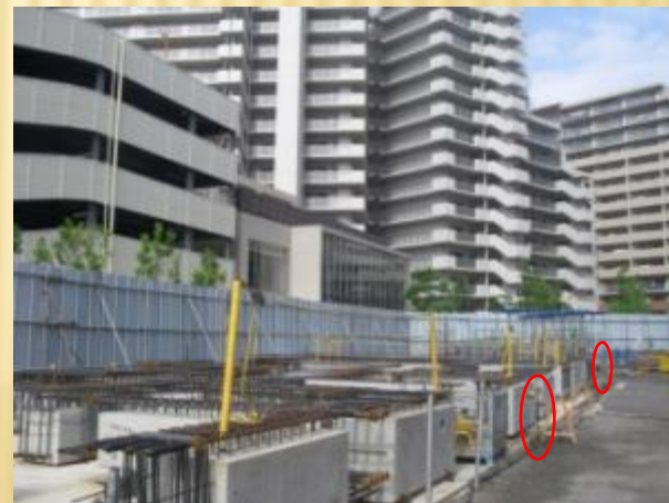
スプリンクラーで車両動線の砂塵抑制
