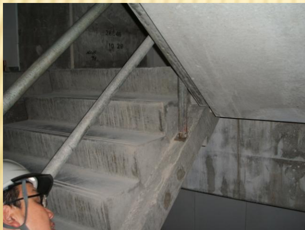
PC階段に取付られた、手摺先行ピースと間仕切り受け
