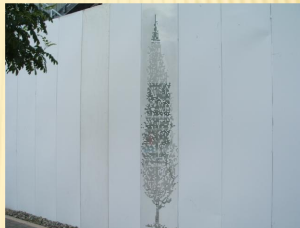
現場内が見えるデザイン仮囲い
